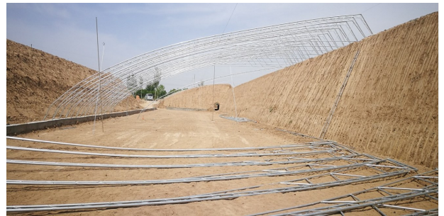
图 4 拱架安装
