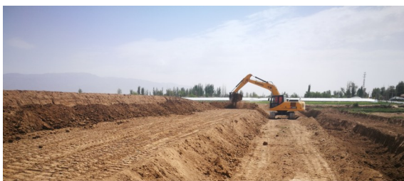
图 3 机打土墙
