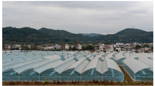
图1 顶部竖式通风型连栋钢架大棚
